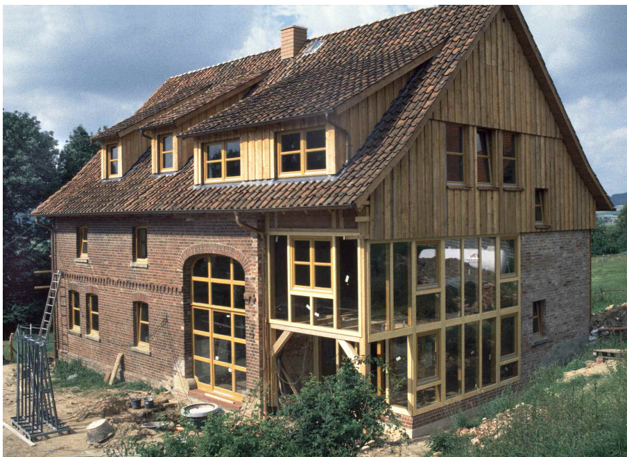
Bild 1: Beispiel für die Nutzung passiver Solarenergie bei Umbau und Sanierung eines Bauernhauses. West- und Nordseite sind außen gedämmt und mit Lärchenholz verkleidet.
