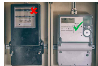
Abbildung 4: Ferraris-Zähler (links), Zweirichtungszähler (rechts), @mpix-foto_stock.adobe.com
